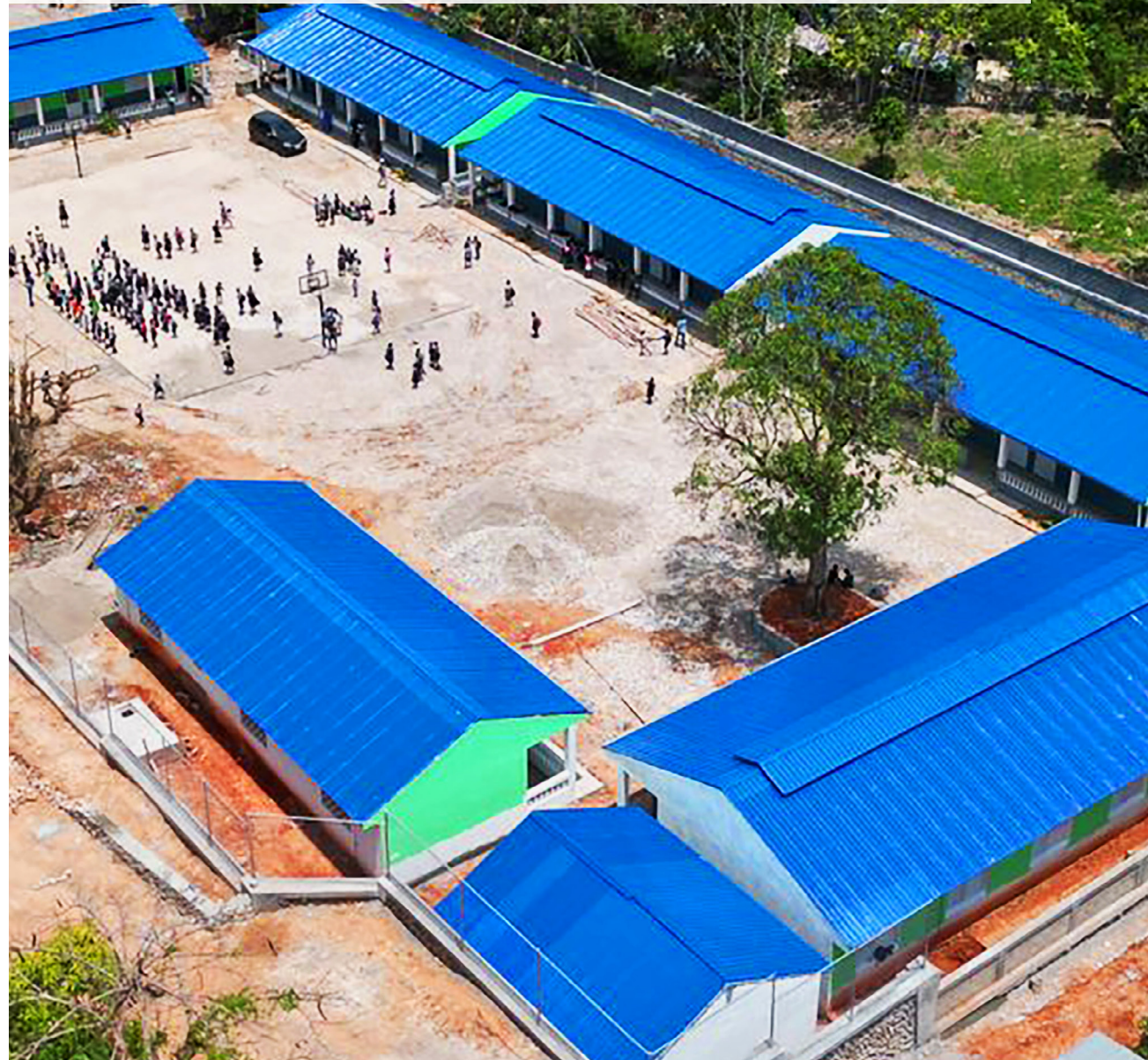
Reconstruction de l'école de Latibolière en cours par la Fondation Digicel.
